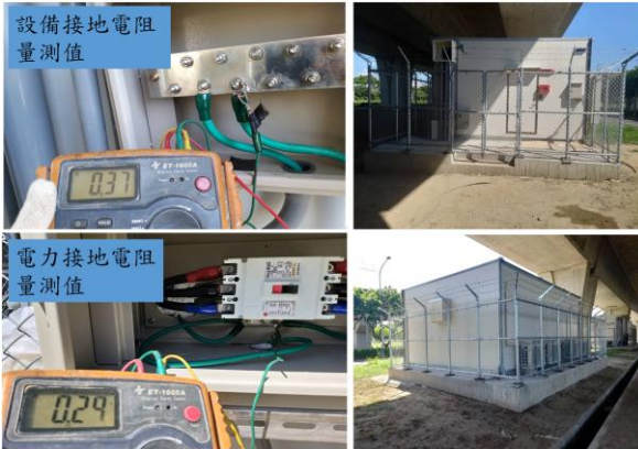
圖 3-1 台南市中繼機房二-接地電阻量測佐證圖
